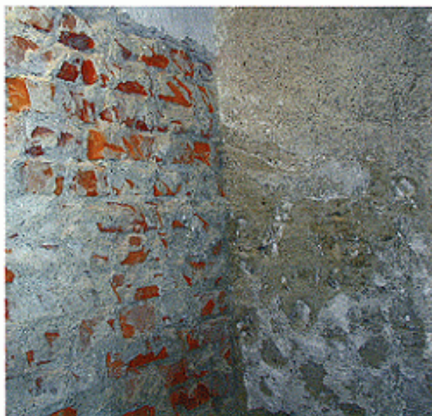
Der alte Putz muss vor der Innenisolation gründlich entfernt werden
